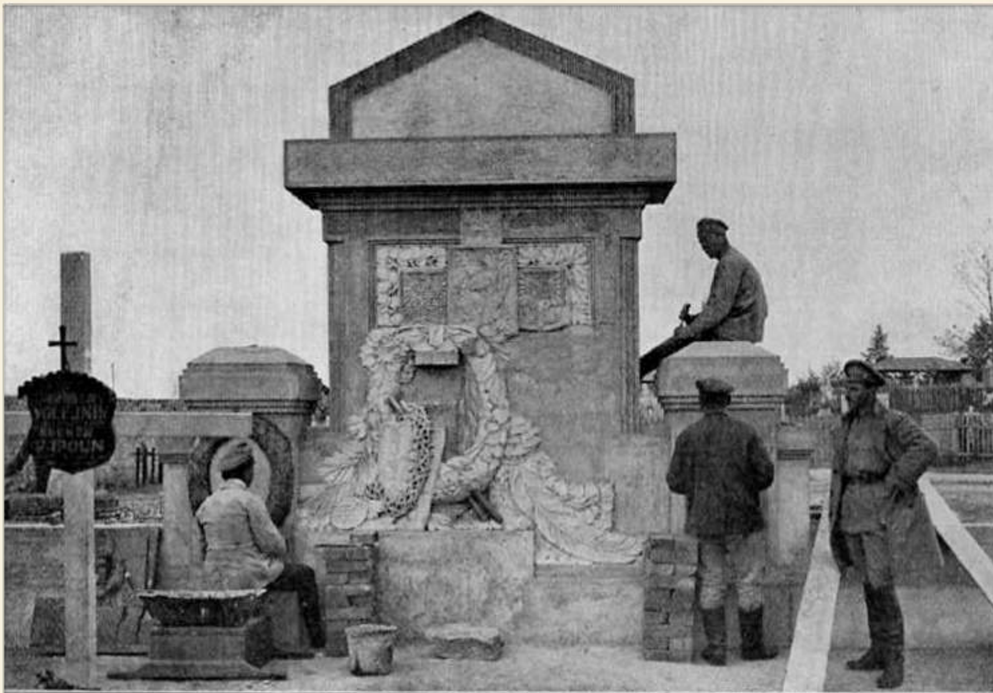
Stavba pomníku na hřbitově v Čeljabinsku.
